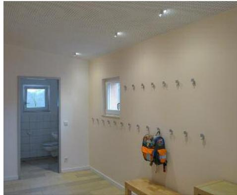
LED Wandfluter mit asymmetrischem Hochleistungsreflektor mit Wallwasher Charakteristik
