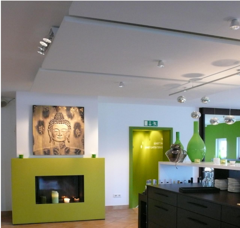
3 Absorptionsplatten unter der Decke sorgen für Raumbedämpfung.
