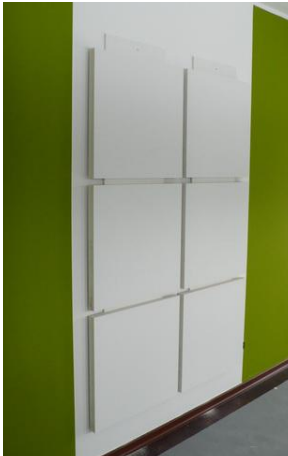
6 Absorptionsplatten ..... unter dem Grafikvorhang (links im Bild).
