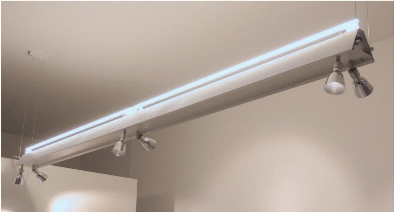
Auf der Länge von 2,415 m sind 2 lückenlos abstrahlende Leuchtstofflampen montiert. 6 Halogenstrahler oder Hochdruckentladungslampen ergänzen das Raumlicht mit gerichteter Beleuchtung.
